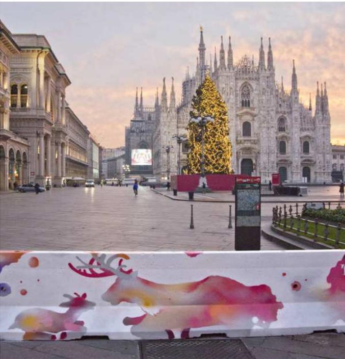
re riempiti di sabbia o acqua per far loro acquistare peso e stabilità) utilizzati per impedire fisicamente il passaggio di autoveicoli in determinate aree.
